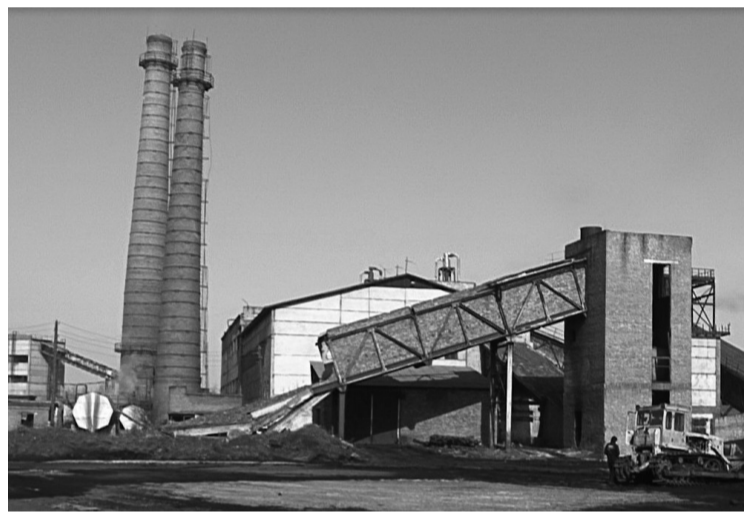
Котельная п. Михайловка
