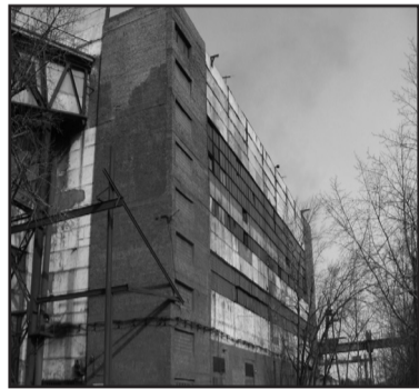
Текущее состояние теплоисточника
