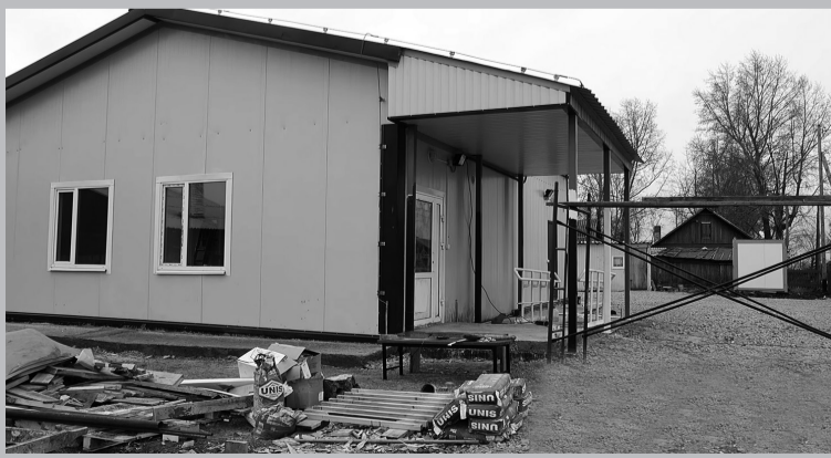
Строящийся ФАП в с. Зерновое
