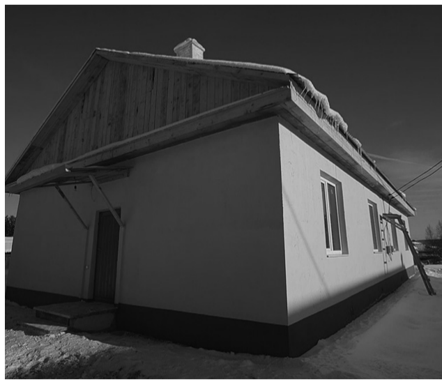
Дом, построенный по программе «Переселение граждан из ветхого и аварийного жилья»
