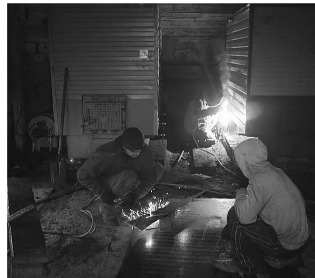
Капитальный ремонт котельной
