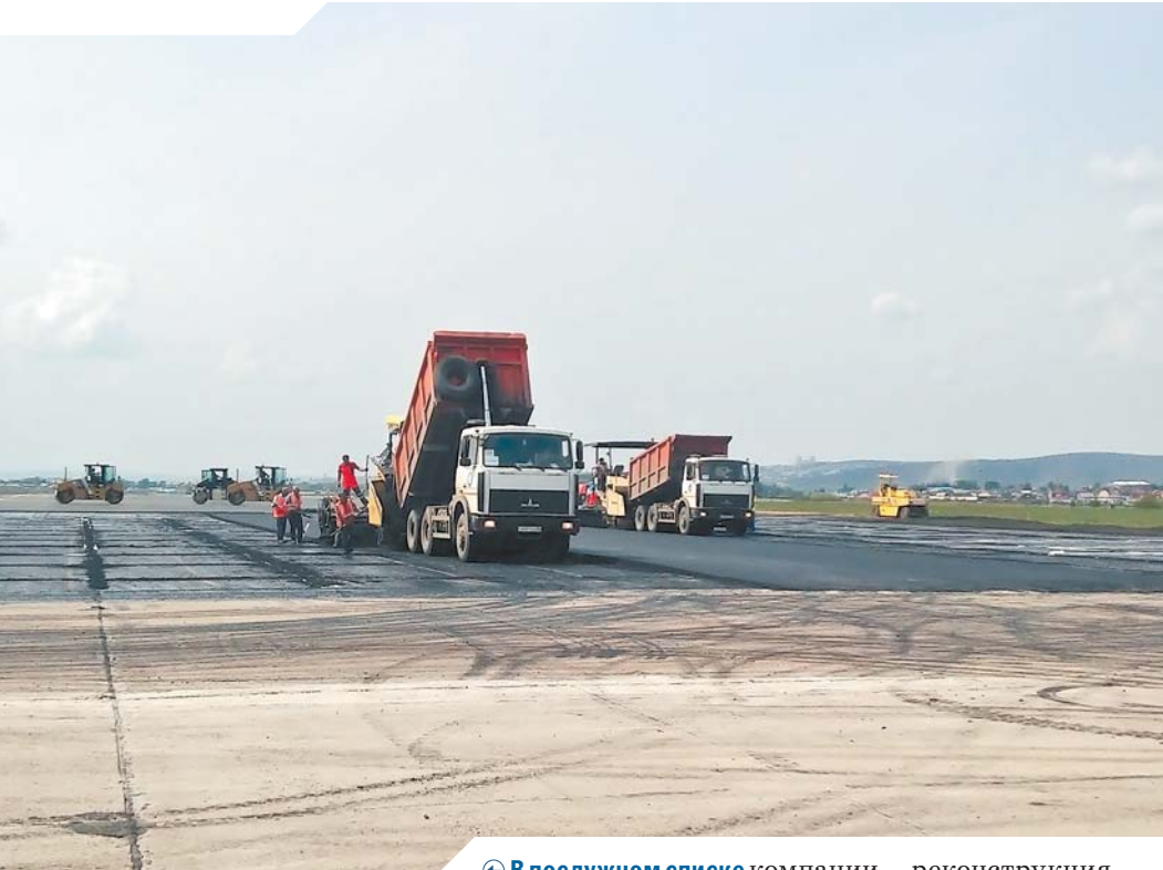
В послужном списке компании — реконструкция ВПП аэропорта «Иркутск».
